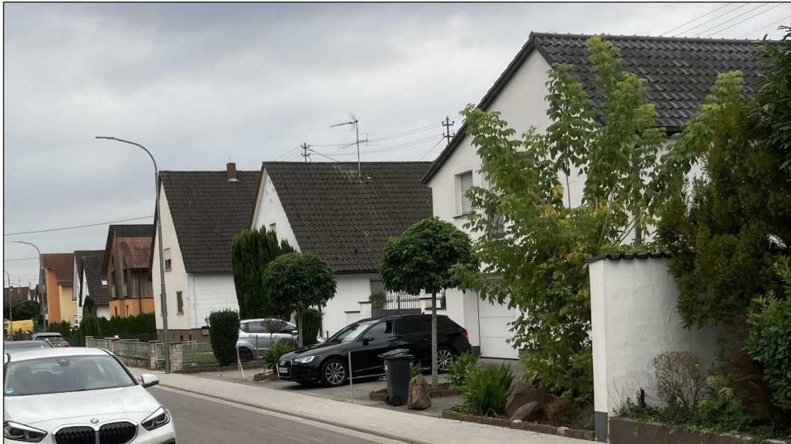
Bebauung im Plangebiet, Quelle: Eigene Aufnahme, 17.09.24
