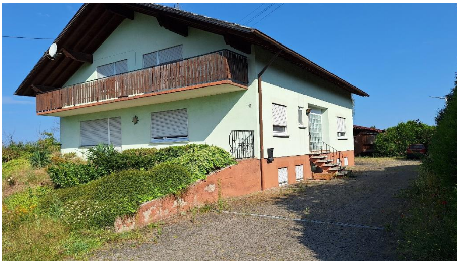
Abb. 2: Bestandsgebäude mit Gartenbrache und Trittrasenstreifen
